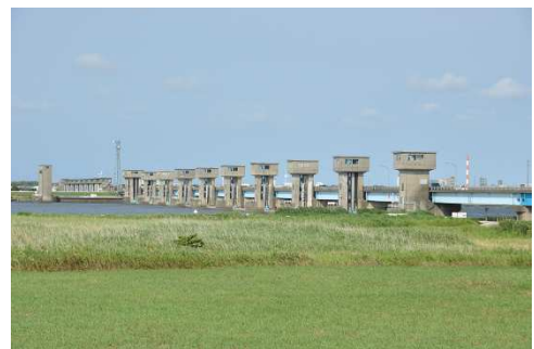
利根川河口堰
