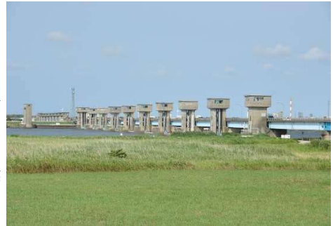
利根川河口堰
