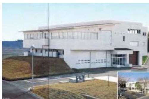
参考）牧野し尿処理場施設写真
