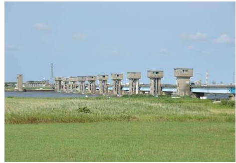
利根川河口堰
